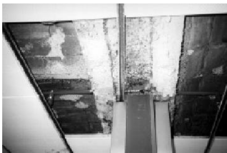
Figura 4. Ignifugación de la estructura metálica en un edificio de oficinas, con material de crisotilo y amosita
