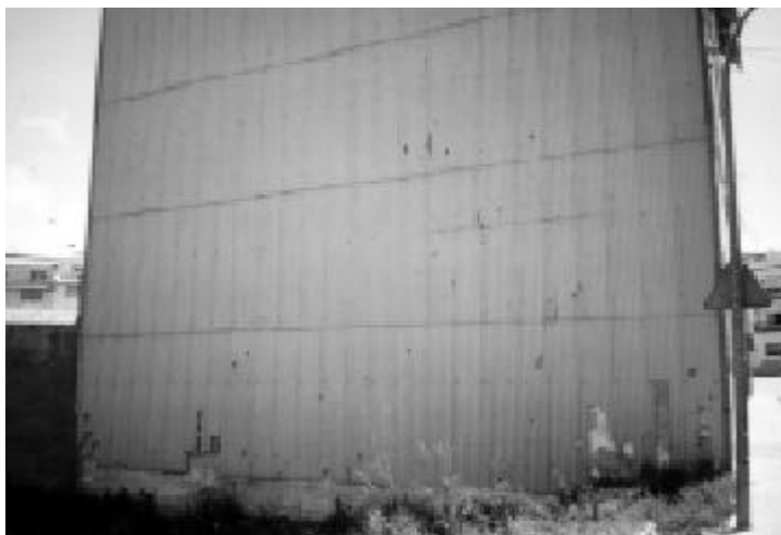
Figura 2. Detalle del estado de las placas de fibrocemento instaladas en un edificio
